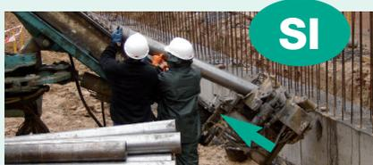
Encender el soplete una vez situado y en el momento de cortar el anclaje.
