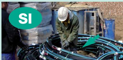
Insertar las varillas de perforación entre dos trabajadores sin subirse a la corredera de la máquina.
