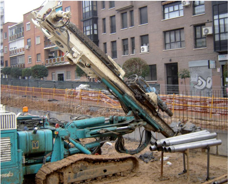
Equipo de perforación y utillaje en borriquetas.
